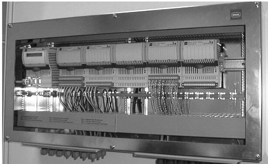
Abb. 4-11 Typischer Aufbau des I.S. 1 Systems
